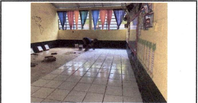
Foto 6: Colocación de piso cerámico en proceso, en las aulas.
