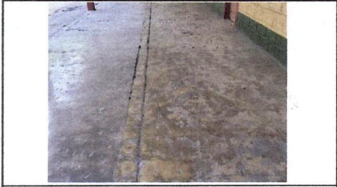
Foto 1: Picado del piso de torta de cemento, en el corredor
