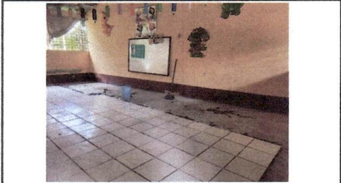
Foto 3: Colocación de piso cerámico en proceso, en las aulas.
