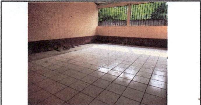
Foto 5: Colocación de piso cerámico en proceso, en las aulas.
